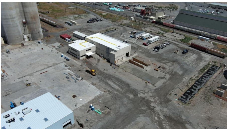
<건설 중인 트웰브 모세스레이크 공장>
